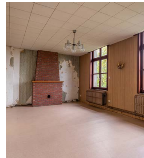
Ruimte op de eerste verdieping
