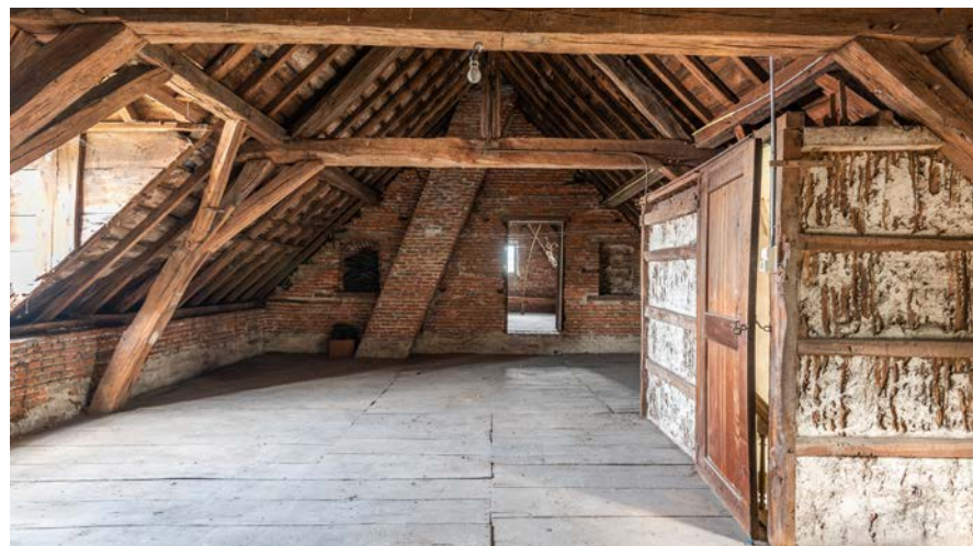
De pastorie beschikt over een ruime zolder
